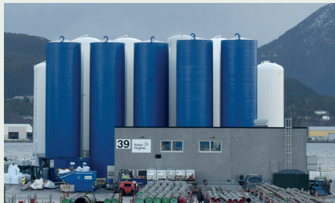
Baker Hughes sitt anlegg sett fra nord.
