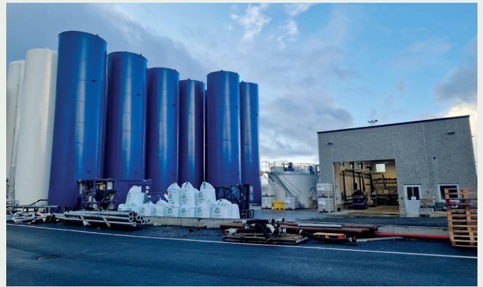
Vestsiden av bygget til Halliburton.
