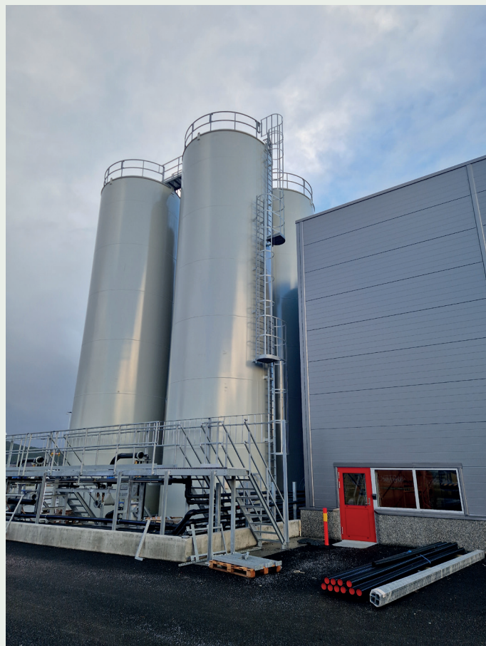
Under tankene er det støpt en betongplate med oppsamling av eventuelle utslipp.
