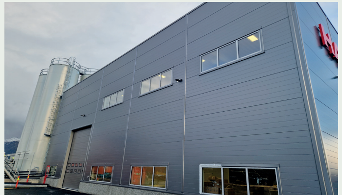
Østsiden av bygget til Halliburton.
