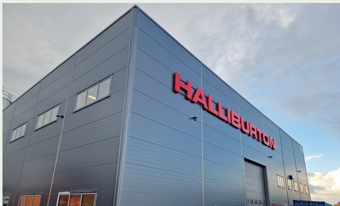
Halliburton bygget sett fra nord-øst.
